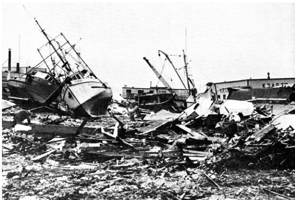
Abb. 9: Trümmerfeld im Hafen von Kodiak, Alaska, nach dem Tsunami vom 27. März 1964 (Foto: R. Kachadorian, USCGS; aus [3])
